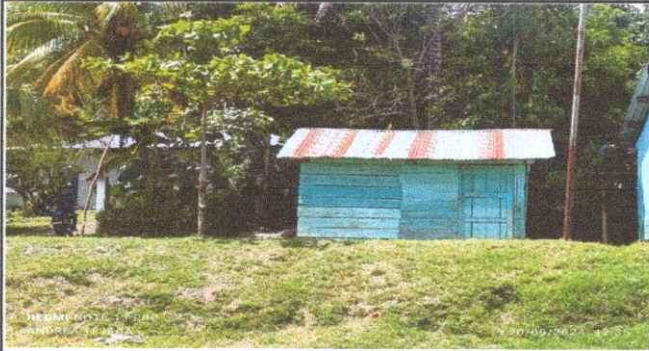
Foto1: Se observa las laminas portantes de la cocina
