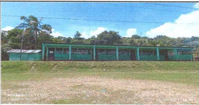
Foto 5: Ampliación de corredor del modulo 2.
